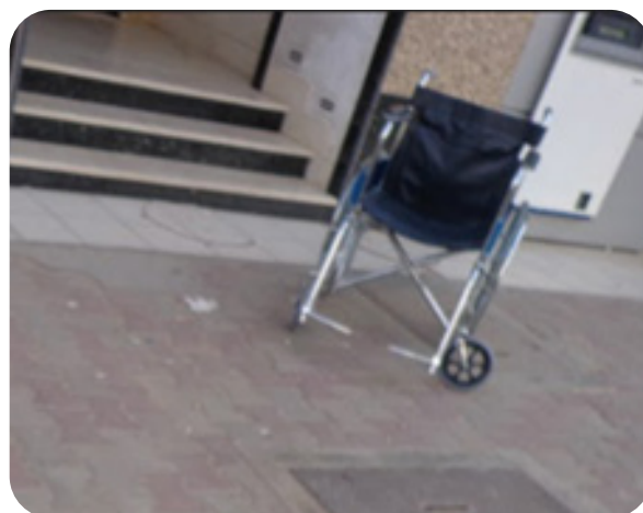
Il n'y a pas de rampe permettant à une personne en fauteuil roulant d'entrer dans la structure
