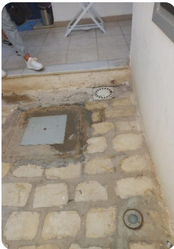
Présence d'un bateau en dehors de la structure
